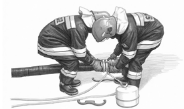
Ryc. 15. Łączenie smoka z wężem ssawnym
