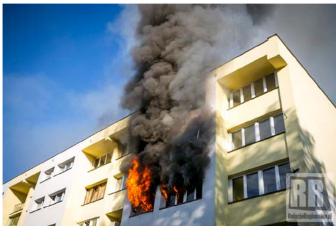
Ryc. 8. Pożar mieszkania na drugiej kondygnacji budynku wielorodzinnego
