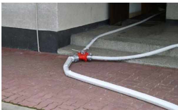
Ryc. 21. Ustawienie rozdzielacza przed wejściem do budynku
