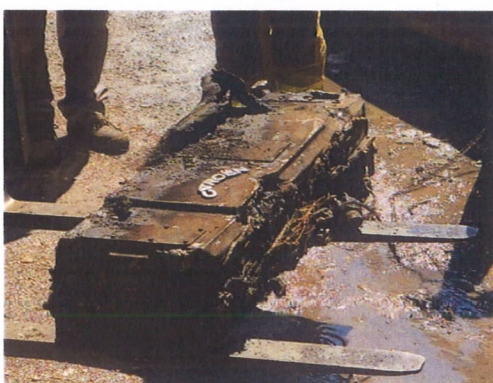
Fot. 22. Bateria po pożarze Źródło: CNBOP-PIB.
