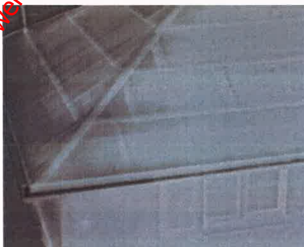
Fot. 6 Widok domku z kamery termowizyjnej Źródło: materiały producenta
