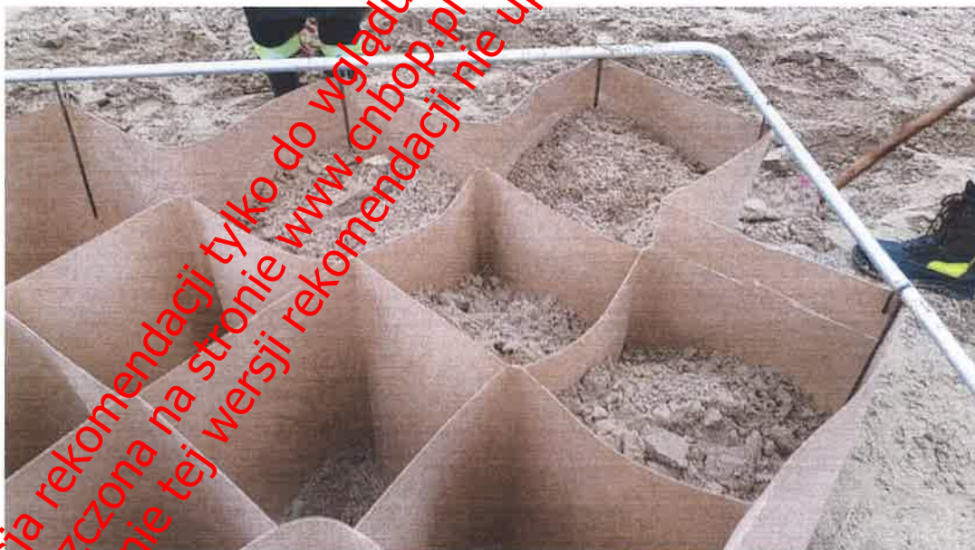
Fot. 12. Wypełnianie modułu DefenCell T2
