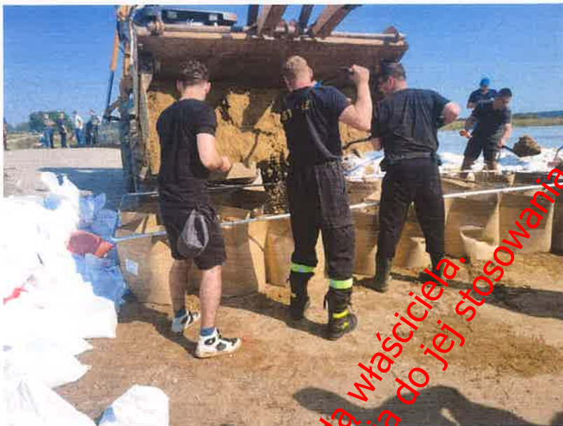
Fot. 7. Wypełnianie modułu DefenCell T2 – warunki rzeczywiste
