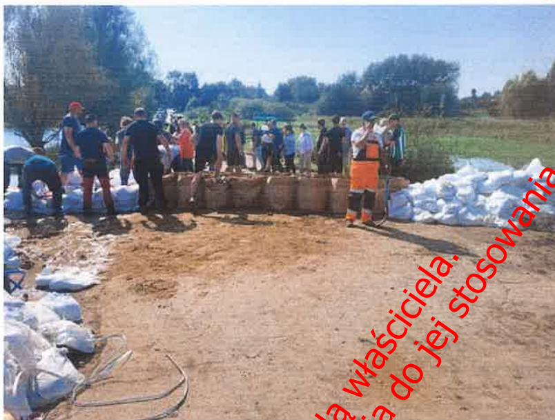
Fot. 9. Widok fragmentu wału przeciwpowodziowego z modulem DefenCell T2 – warunki rzeczywiste
