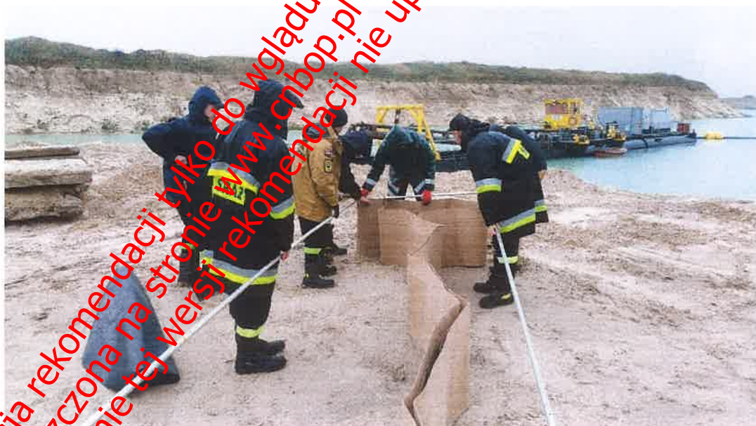
Fot. 10. Montaż stelaża na module DefenCell T2
