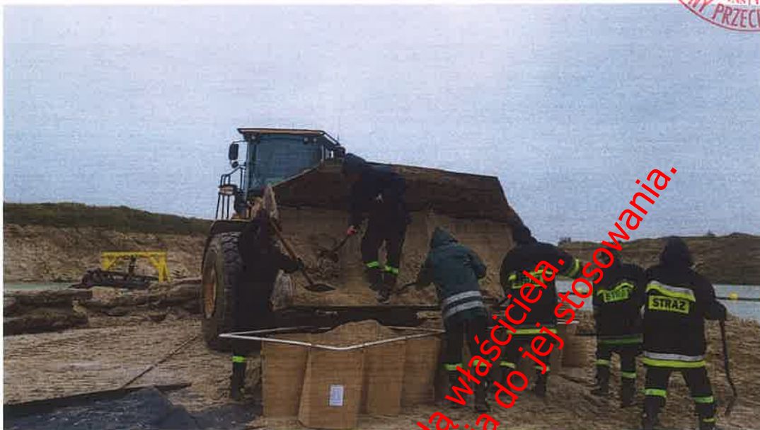
Fot. 13. Wypełnianie modułu DefenCell T2 z wykorzystaniem ładowarki
