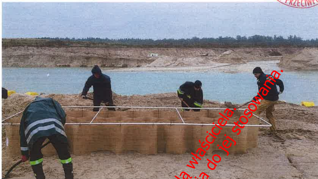
Fot. 11. Wypełnianie modułu DefenCell T2 - ręcznie
