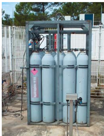
Ryc. 2. Zestaw butli z wodorem V18, obok tablice ostrzegawcze
