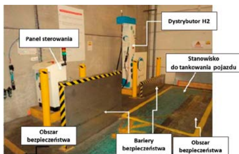
Ryc. 28. Dozownik do wózka widłowego (Air Liquide)
