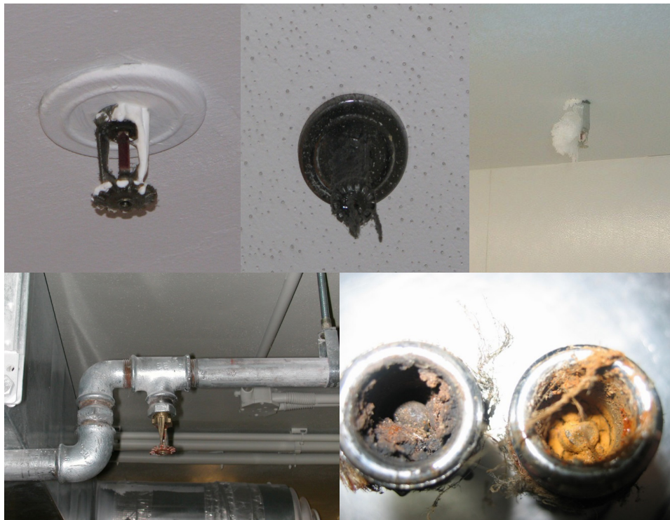
Ryc. 3. Wybrane przykłady błędów eksploatacji w instalacjach stałych urządzeń tryskaczowych Źródło: Archiwum CNBOP-PIB.
