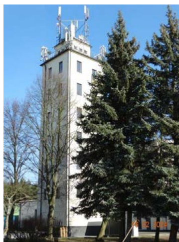
■ Budynek wieży przeciwpożarowej W
