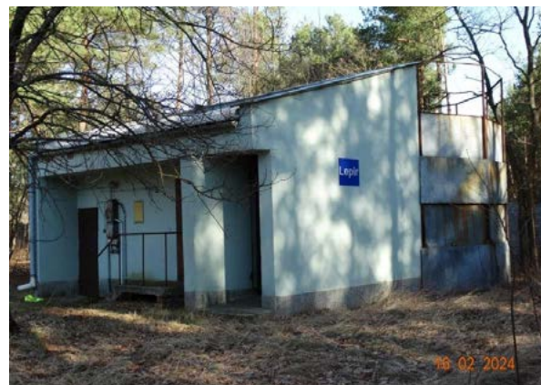
■ Budynek „Lepir” (stanowisko badawcze)
