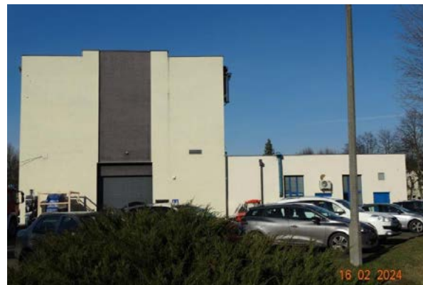
■ Budynek hali badawczej H i budynek P
