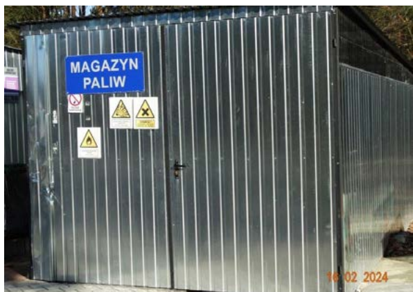
■ Wiata blaszana (magazyn paliw)
