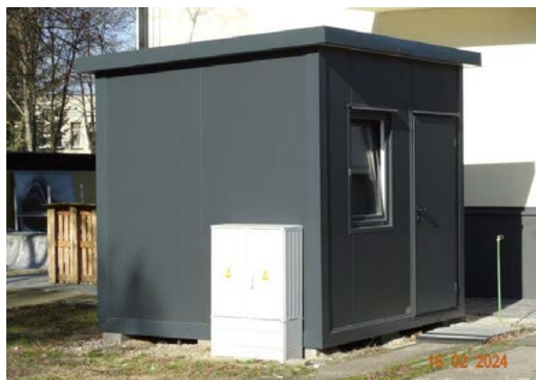
■ Pawilon z płyty warstwowej (obsługa wagi)
