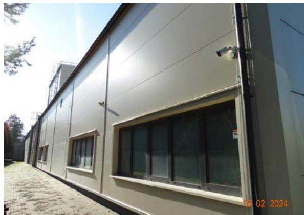
■ Budynek hali badawczej L [widok od strony ogrodzenia]
