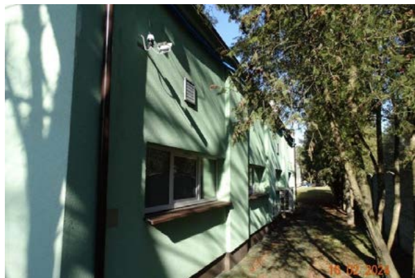
■ Budynek G (widok od strony ogrodzenia)
