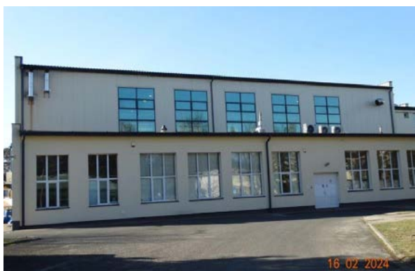
■ Budynek P („prototypownia” i laboratoria BA)
