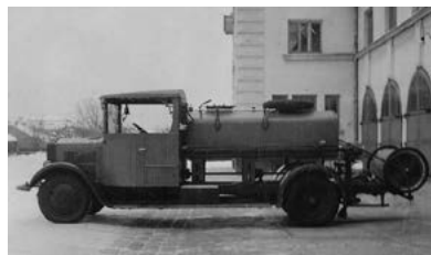
Samochód Miejskiej (a więc zawodowej) Straży Pożarnej w Stanisławowie z 1937 r., z zakrytą kabiną załogi, zbiornikiem na wodę i autopompą (stan blach wskazuje na samodzielne wykonanie zabudowy) Źródło: Centralne Muzeum Pożarnictwa w Mysłowicach.
