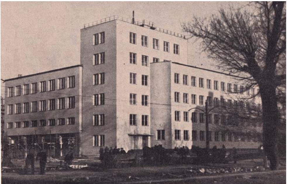
Gmach Centralnego Ośrodka Wyszkolenia Pożarniczego w kształcie podobnym do projektu Tuliszковского sprzed 15 lat
