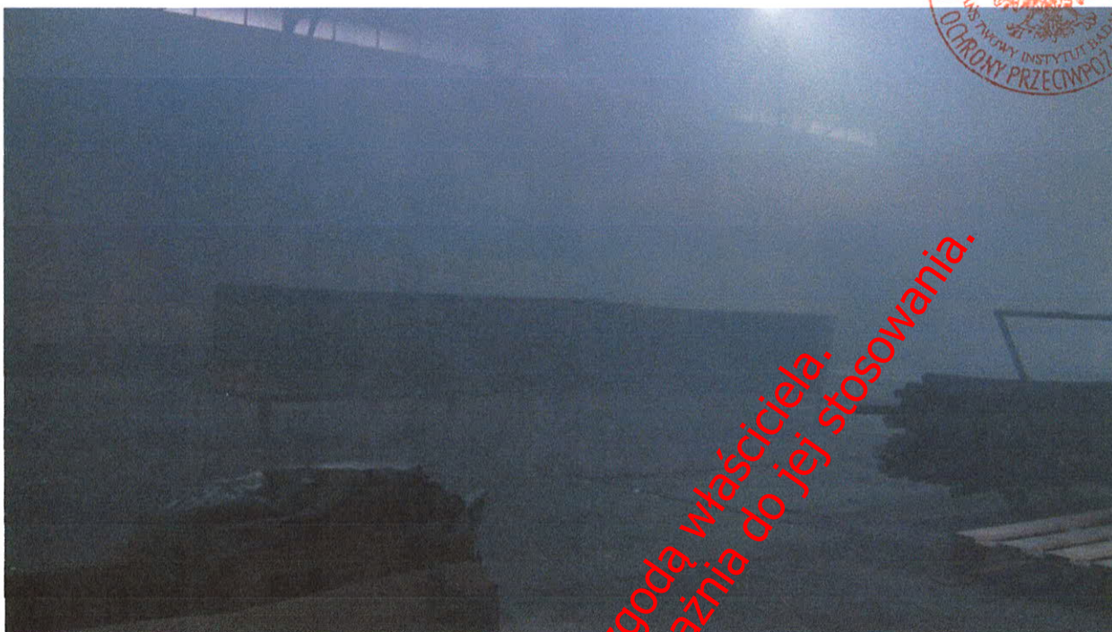
Fot. 20 Stos po ugaszeniu i częściowym odymieniu hali badawczej
