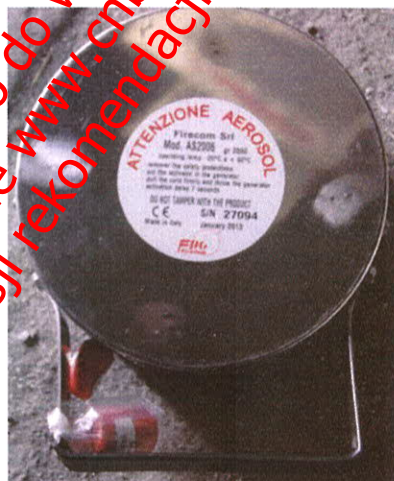
Fot. 2 Urządzenie gaśnicze FPG Aerosol typu OFF-FIRE w odmianie AS2006
