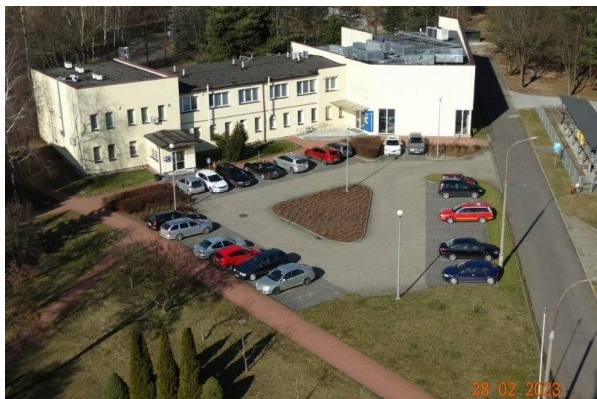
■ Budynek C z salą szkoleniową
