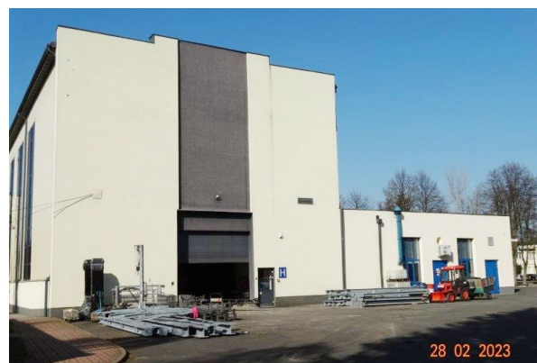
■ Budynek hali badawczej H i budynek P
