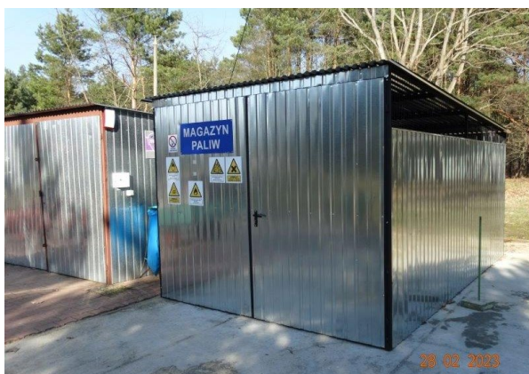
■ Wiata blaszana (magazyn paliw)
