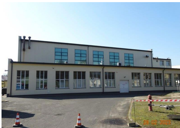
■ Budynek P („prototypownia” i laboratoria BA)
