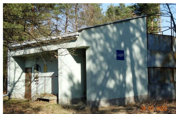
■ Budynek „Lepir” (stanowisko badawcze)
