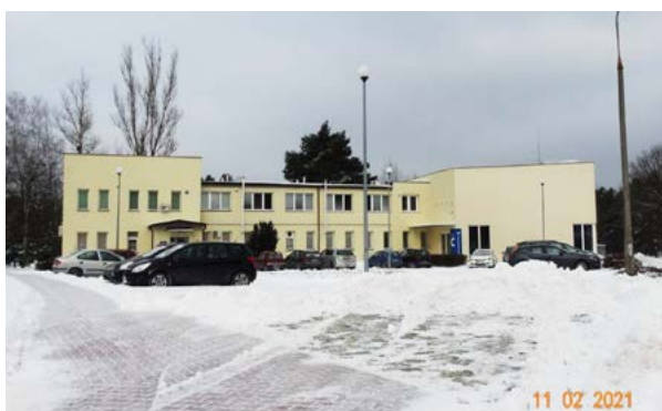
■ Budynek C z salą szkoleniową
