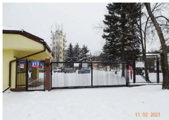
■ Brama techniczna [pożarowa]
