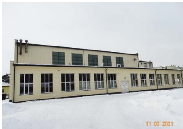
■ Budynek P („prototypownia” i laboratoria BA)
