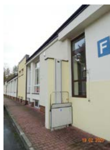
■ Budynek F z salą szkoleniową
