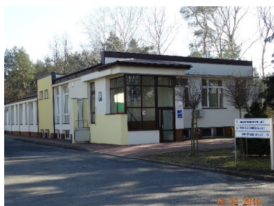
■ Budynek F z salą szkoleniową
