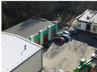
■ Budynek badawczy L, G, F [widok z wieży]
