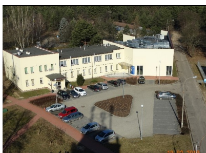
■ Budynek C z salą szkoleniową
