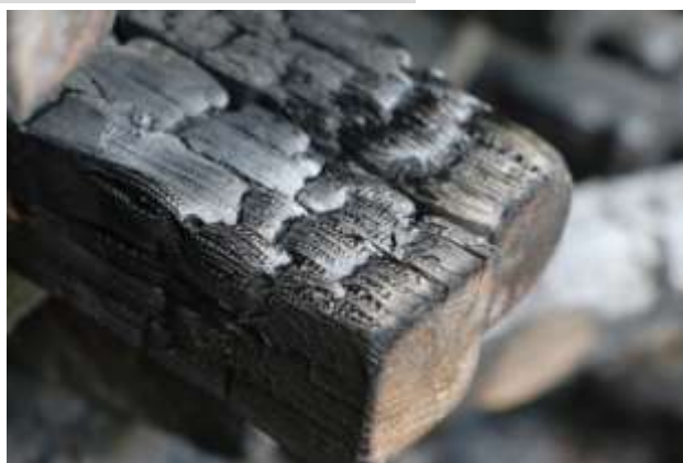
Ryc. 13. Szklista warstewka izolująca, powstała na skutek zastosowania gaśnicy proszkowej ABC
