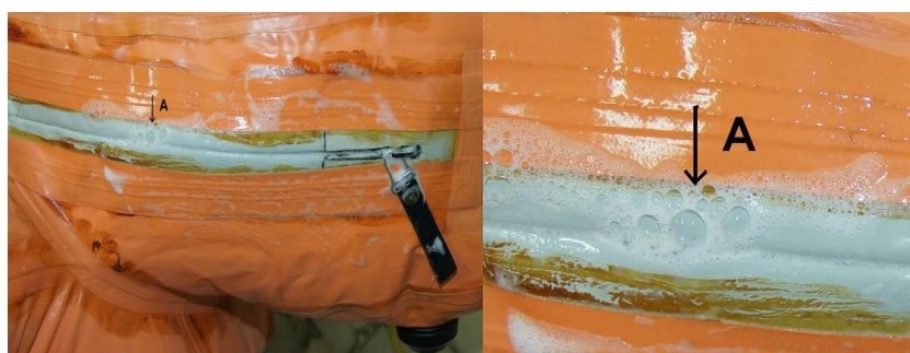
Ryc. 34. Pęcherze powietrzne w miejscu nieszczelności Źródło: opracowanie własne
