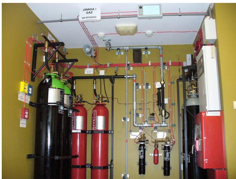
Zdj. 1 Przykładowa instalacja SUG gazowych, wykorzystywana do celów szkoleniowych. (Źródło: InGas Sp. z o.o.)
