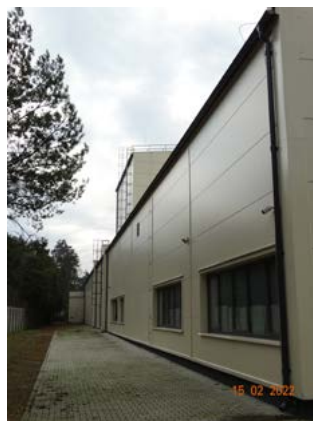
■ Budynek hali badawczej L (widok od strony ogrodzenia)
