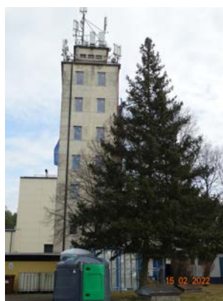
■ Budynek wieży przeciwpożarowej W
