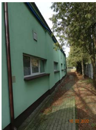
■ Budynek G (widok od strony ogrodzenia)
