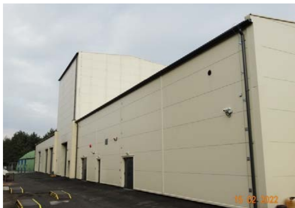
■ Budynek hali badawczej L
