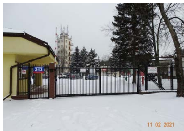
■ Brama techniczna [pożarowa]
