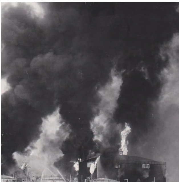
Ryc. 5. Płonący zbiornik z ropą oraz działania chłodzące zbiorników sąsiednich
