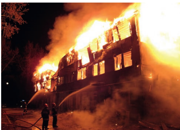
Ryc. 65. Widok pożaru od strony placu wewnętrznego (godz. 1.36)
