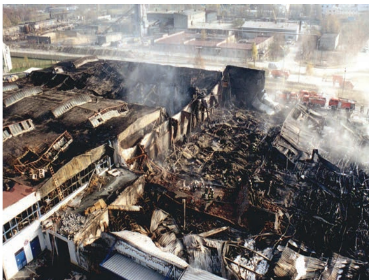
Ryc. 52. Widok zniszczeń spowodowanych pożarem w zakładzie POLARCUP
