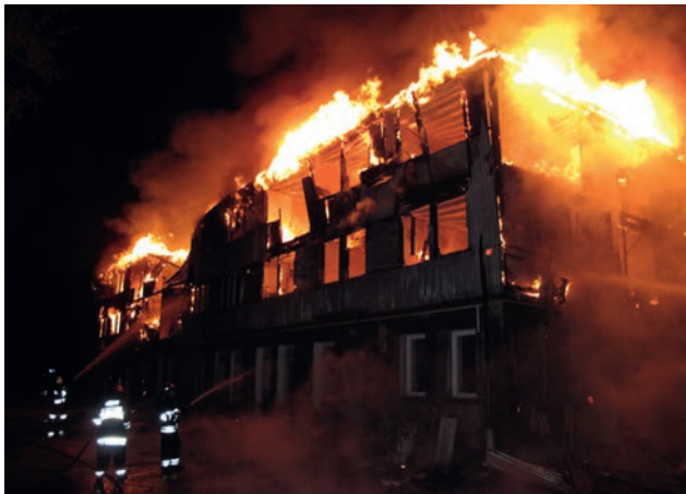
Ryc. 66. Widok pożaru od strony placu wewnętrznego (godz. 1.36)
