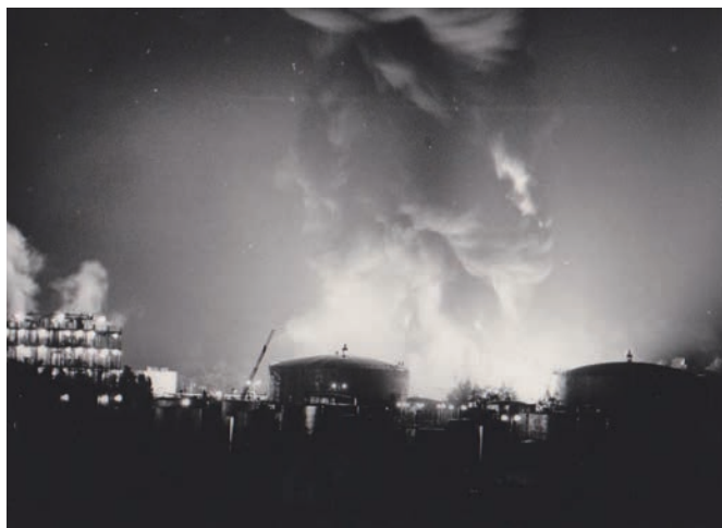
Ryc. 6. Moment przed wyrzutem ropy ze zbiornika Źródło: Centralne Muzeum Pożarnictwa w Mysłowicach.
