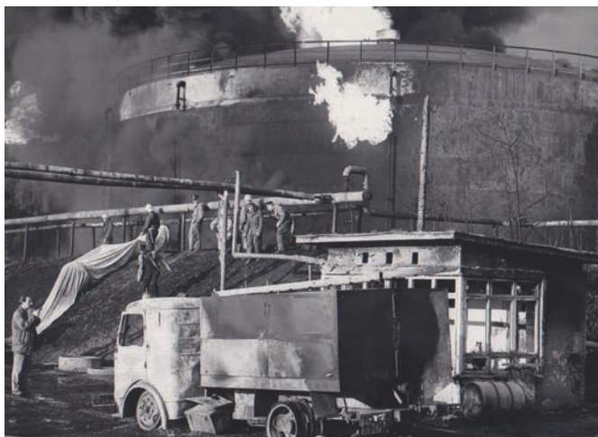
Ryc. 8. Zniszczenia spowodowane wyrzutem płonącej ropy ze zbiornika
