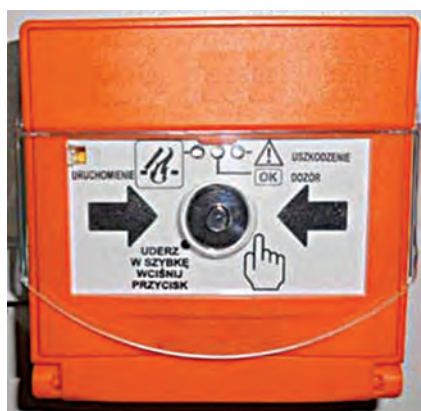
Ryc. 150. Ręczny przycisk oddymiania bez oznaczenia „ODDYMianie”. Ten brak grozi dezinformacją użytkownika co do przeznaczenia wyrobu i właściwego momentu jego użycia
