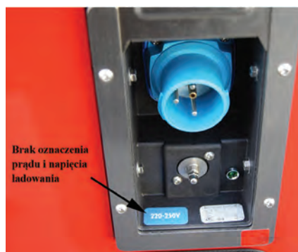
Ryc. 115. Brak oznaczenia prądu i napięcia ładowania może doprowadzić do uszkodzenia sprzętu
