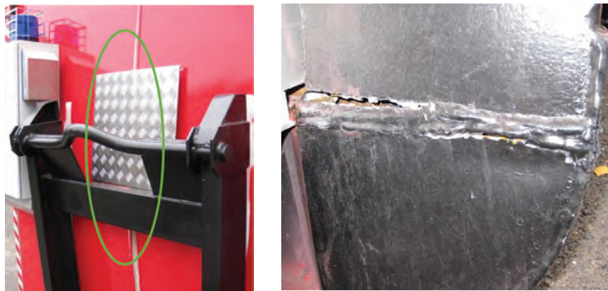
Ryc. 124. Pęknięcie ramy nośnej kontenera – zagrożenie dla użytkownika w trakcie zakładania kontenera na nośnik i zdejmowania z niego
