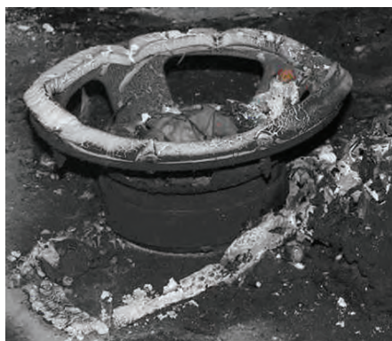
Ryc. 144. Palący się głośnik do DSO, który oderwał się od konstrukcji. Defekt uszkodził linię głośnikową, stwarzając zagrożenie dla użytkowników obiektu i/lub ratowników
