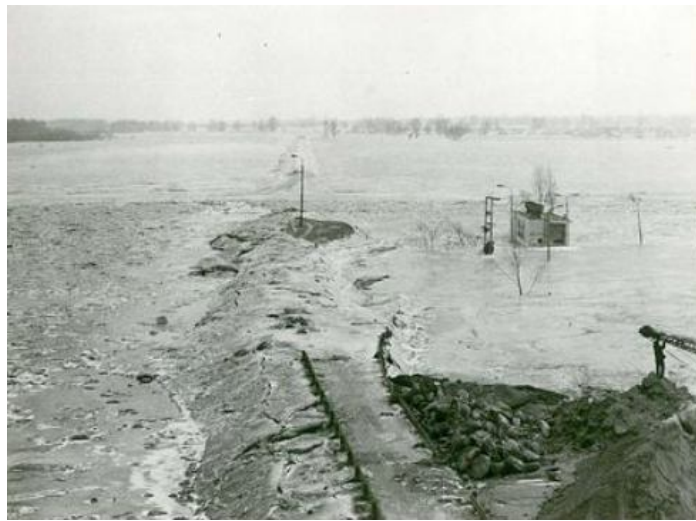
Rys. 4.6 Przerwany wał przeciwpowodziowy i zatopiona pompownia Radziwie-Tokary-Foto IMGW Warszawa [66]
