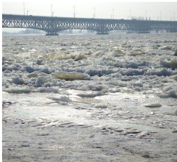
Rys. 2.3 Zator lodowy na Wiśle 2011r. [33]
