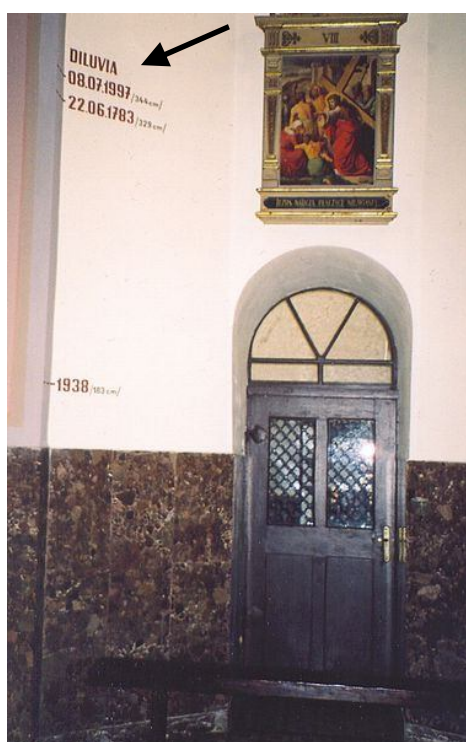
Rys. 4.13 Ściana w lewej nawie bocznej kościoła franciszkanów, zawierająca wskaźniki ile wynosił stan wody w kościele podczas powodzi [77]
