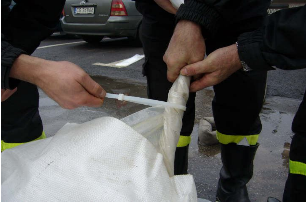
Rys. 7.16 Pierwsze zapięcie opaską plastikową rękawa przeciwpowodziowego napelnionego wodą [145]
