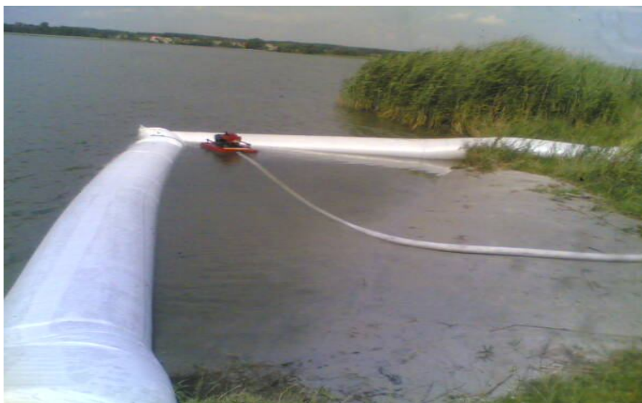
Rys. 7.24 Utworzenie wału przeciwpowodziowego na zbiorniku wodnym w celu zabezpieczenia przed rozlaniem substancji ropopochodnych [145]
