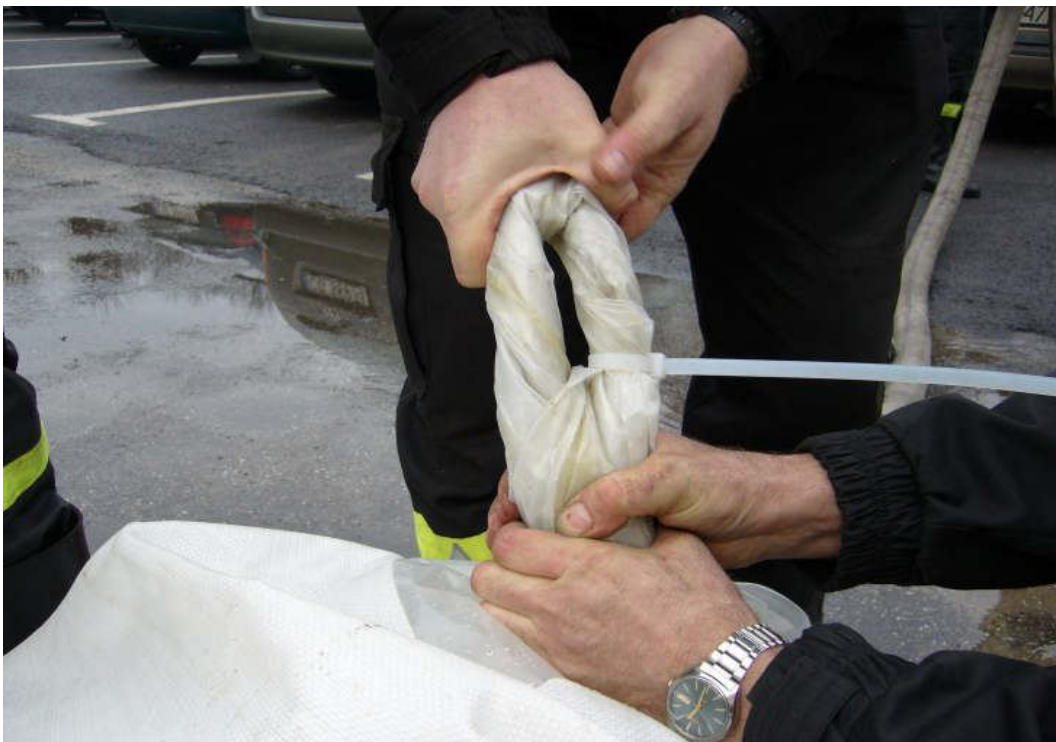
Rys. 7.17 Skręcenie i zagięcie pozostałej części rękawa przeciwpowodziowego w celu ponownego zapięcia opaską plastikową [145]
