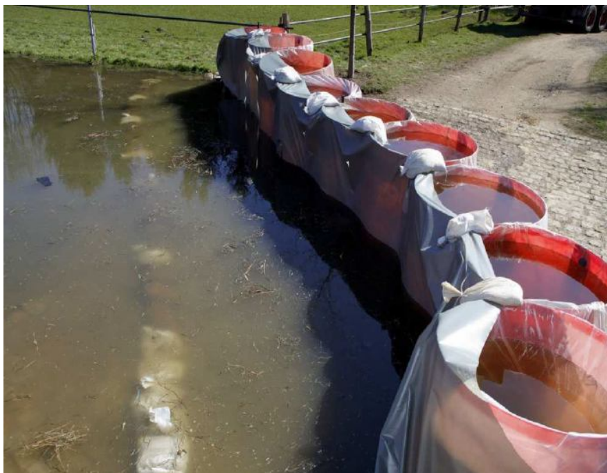
Rys.7.13. Zastosowanie pionowych rękawów przeciwpowodziowych do ochrony zagrożonego terenu [159]
