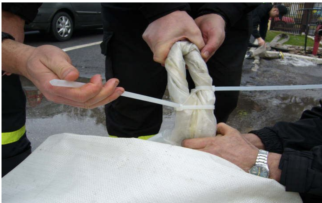
Rys. 7.18 Powtórne zapięcie końca rękawa przeciwpowodziowego napelnionego wodą [145]
