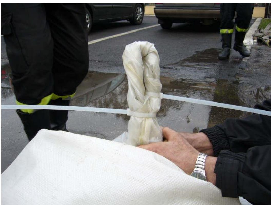
Rys. 7.19 Prawidłowe zawiązanie końcówki wewnętrznej części rękawa przeciwpowodziowego napelnionego wodą [145]
