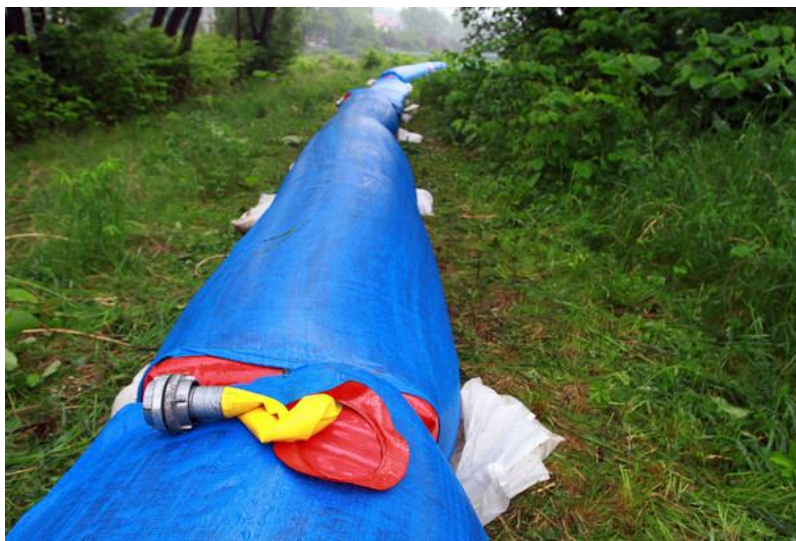
Rys. 7.21 Rękawy ułożone w celu zabezpieczenia cmentarza w Jeleniej Górze autor Fot. Marcin Oliva Soto) [161]
