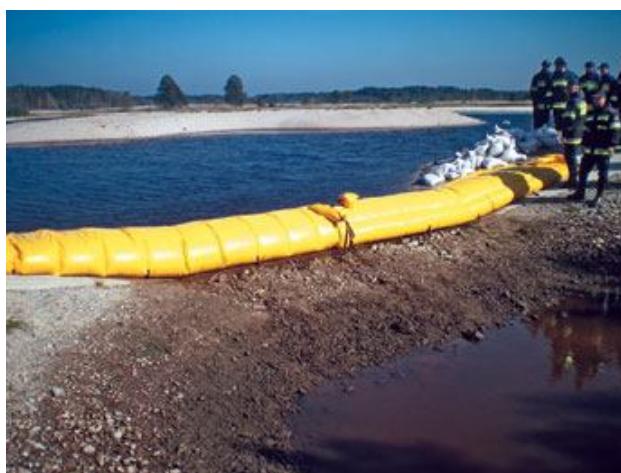
Rys. 7.22 Rękawy ułożone wzdłuż rzeki w celu zabezpieczenia terenu przed zalaniem [154]
