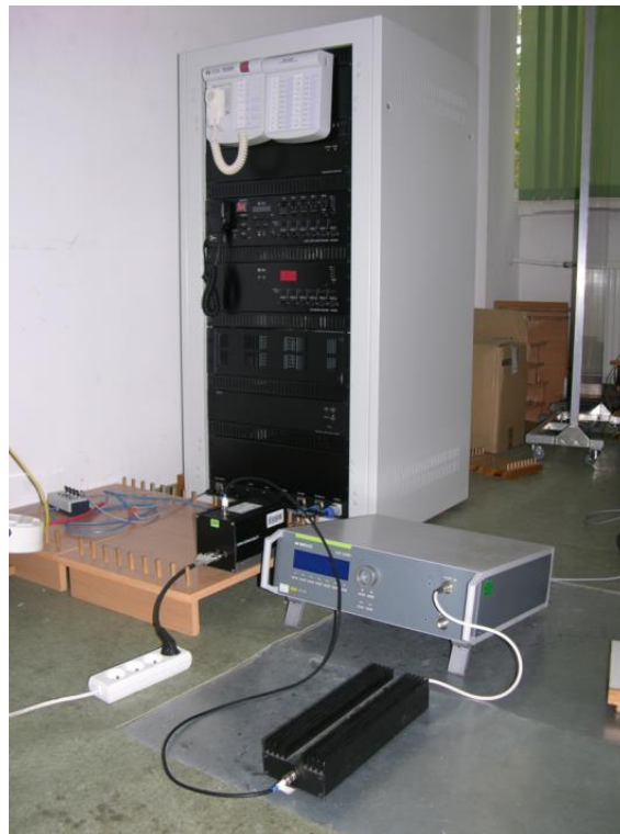
Ryc. 6. Wyposażenie do badania odporności na zaburzenia przewodzone indukowane przez pola elektromagnetyczne Źródło: opracowanie własne
